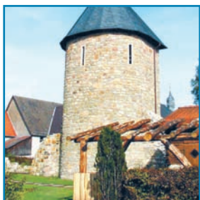
Der mächtige Wehrturm in der Oberstadt Bad Wünnenbergs
